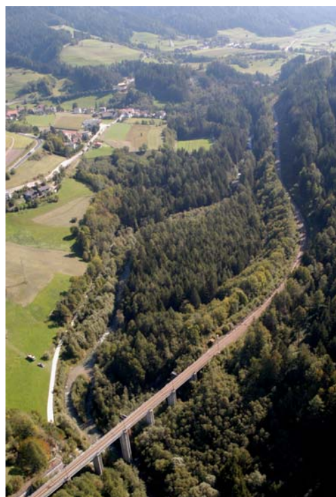
Rienzschlucht mit hohem Nadelwaldanteil unterhalb von Percha
